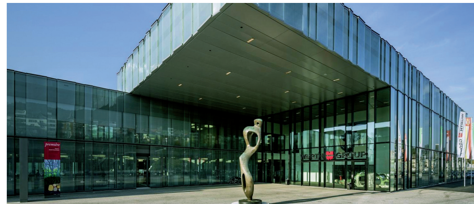
Würth-Haus Rorschach, Churerstrasse 10
